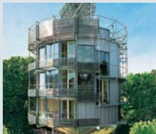
Heliotrop Freiburg, Deutschland
